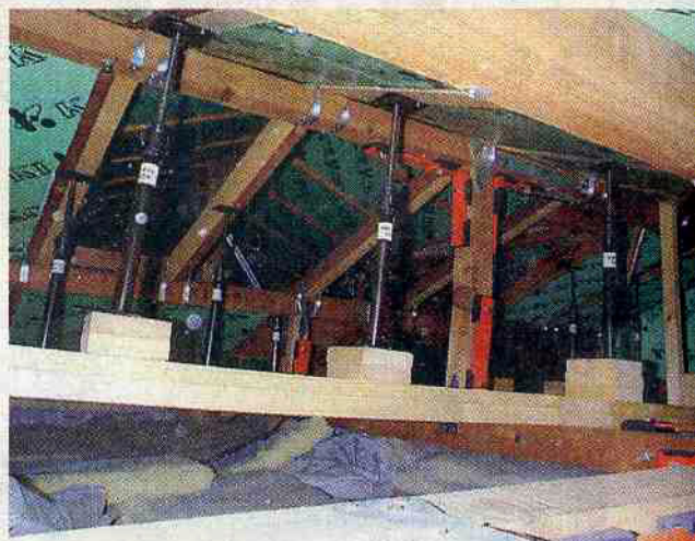
役に立たない耐震金具が林立する認知症姉妹宅の屋根裏。現在はほとんどが撤去されている—埼玉 県富士見市（石田隆彦・一級建築士提供）
